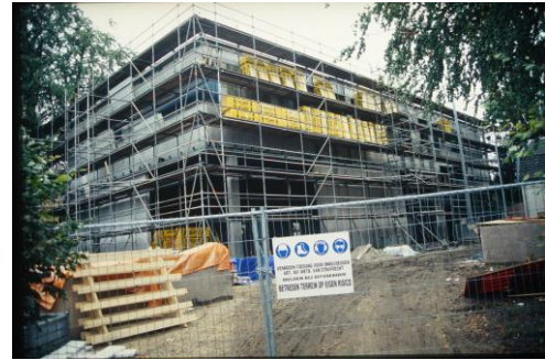
Regenboogkerk Hilversum in aanbouw, 2000
